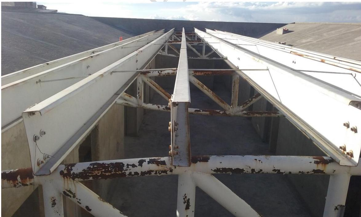
Fotografía 4. Estructura de cubierta con muestras de deterioro.
