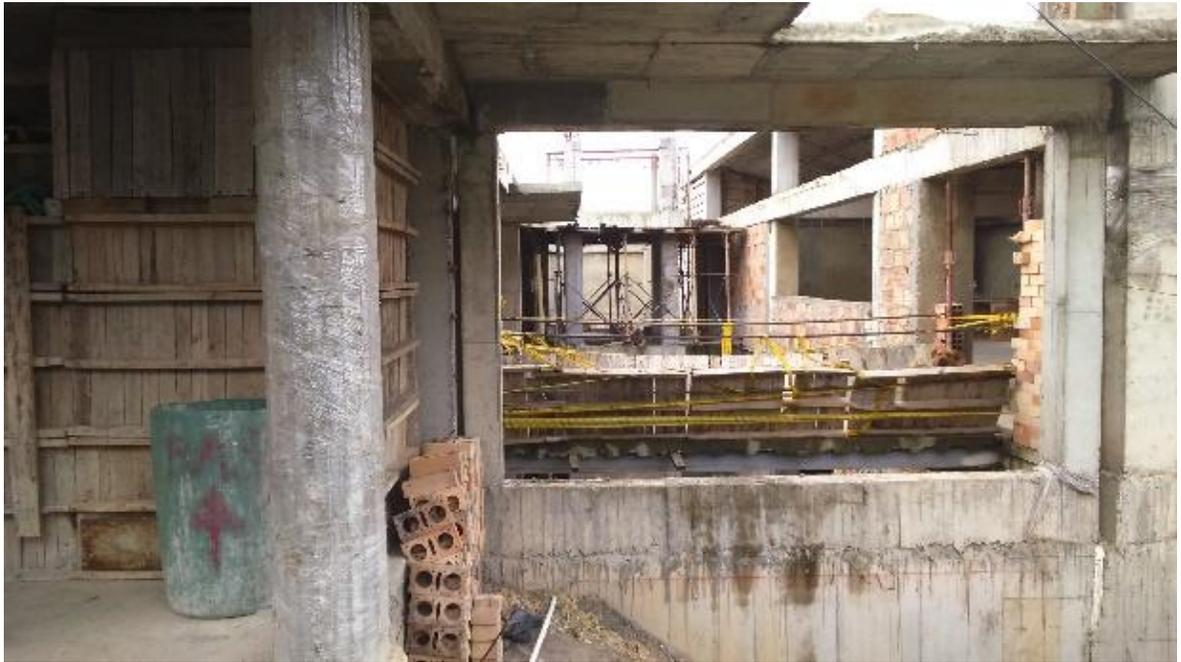
Fotografía 5. Muros con formaletas, secciones sin desencofrar. Material del contrato No. 1698 de 2011
